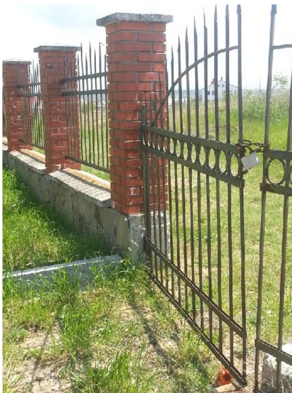
Les grilles ne ferment plus correctement et les allées sont envahies par les herbes.
