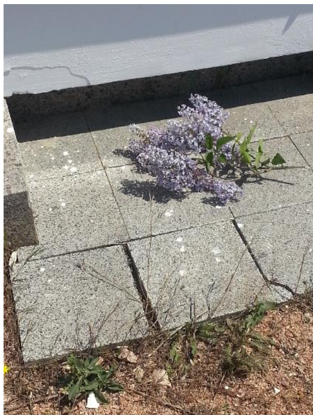
Les dalles des stèles sont descellées.
