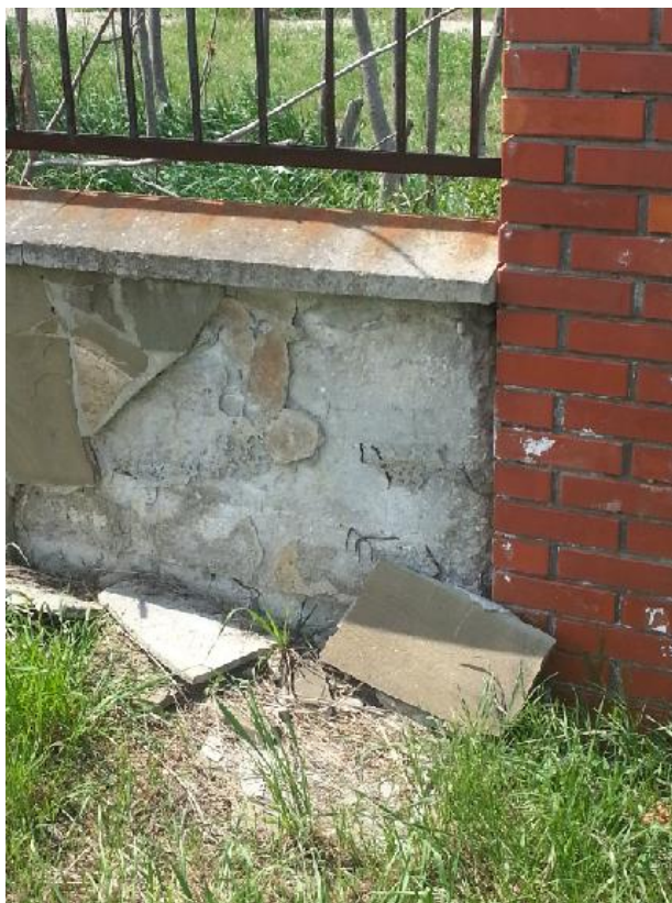
Les plaques couvrant le muret sont descellées et la rouille de la grille a déteint sur le muret.
