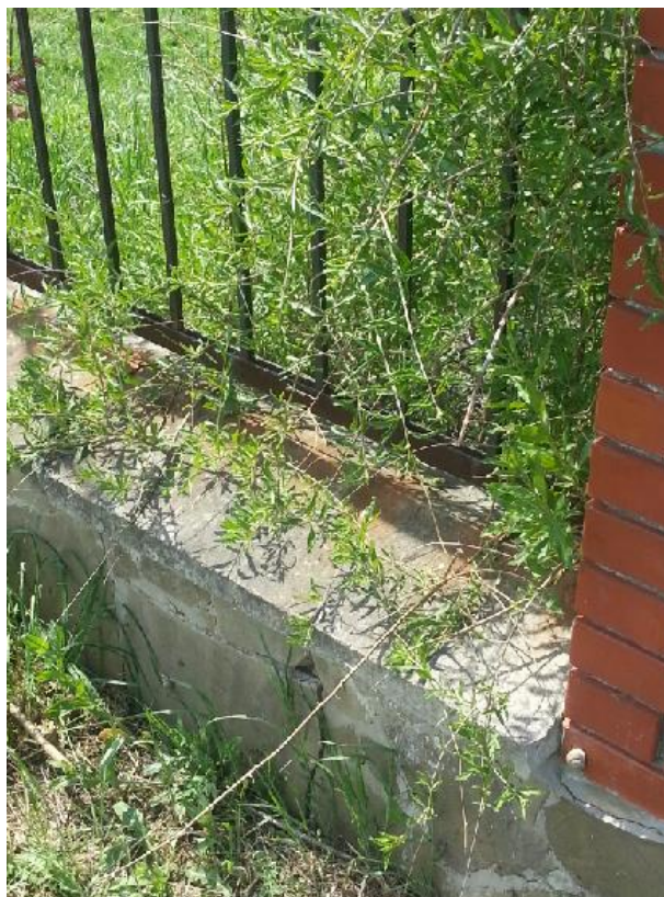
Les herbes ont envahi également la clôture du cimetière.
